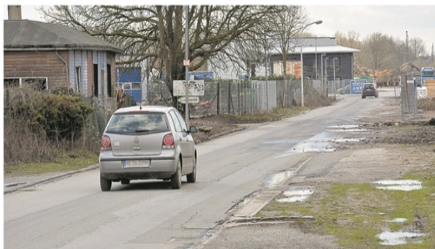
Auf den schlechten Straßenzustand des Ikenkamps will die Stadt durch Schilder hinweisen, ausgebessert wird die Fahrbahn nur im Notfall.
